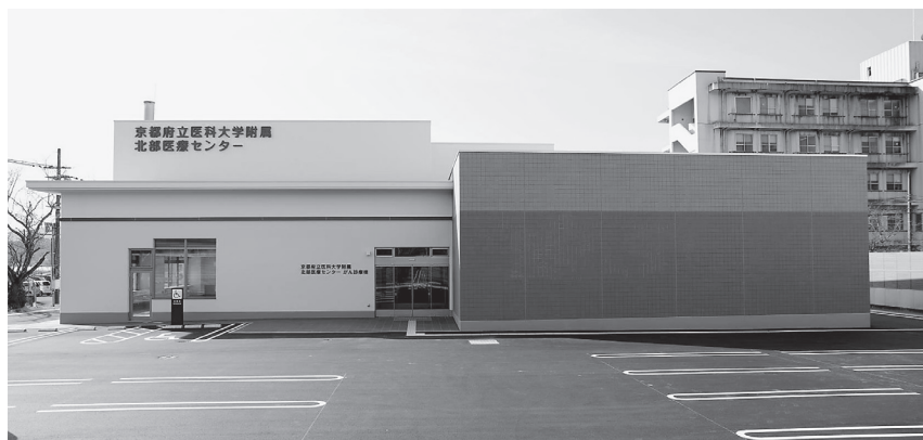
図1 令和2年に竣工したがん診療棟と昭和51年建設された北病棟（右後方）
